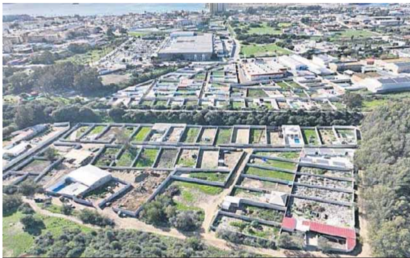
Imagen aérea de la macrounificación que se estaba construyendo y la Junta ha precintado.
