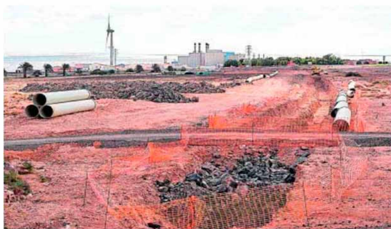
Foto de archivo de la obra de la tubería que enlaza La Herradura con la desaladora. JAVIER MELIÁN / ACFI PRESS
