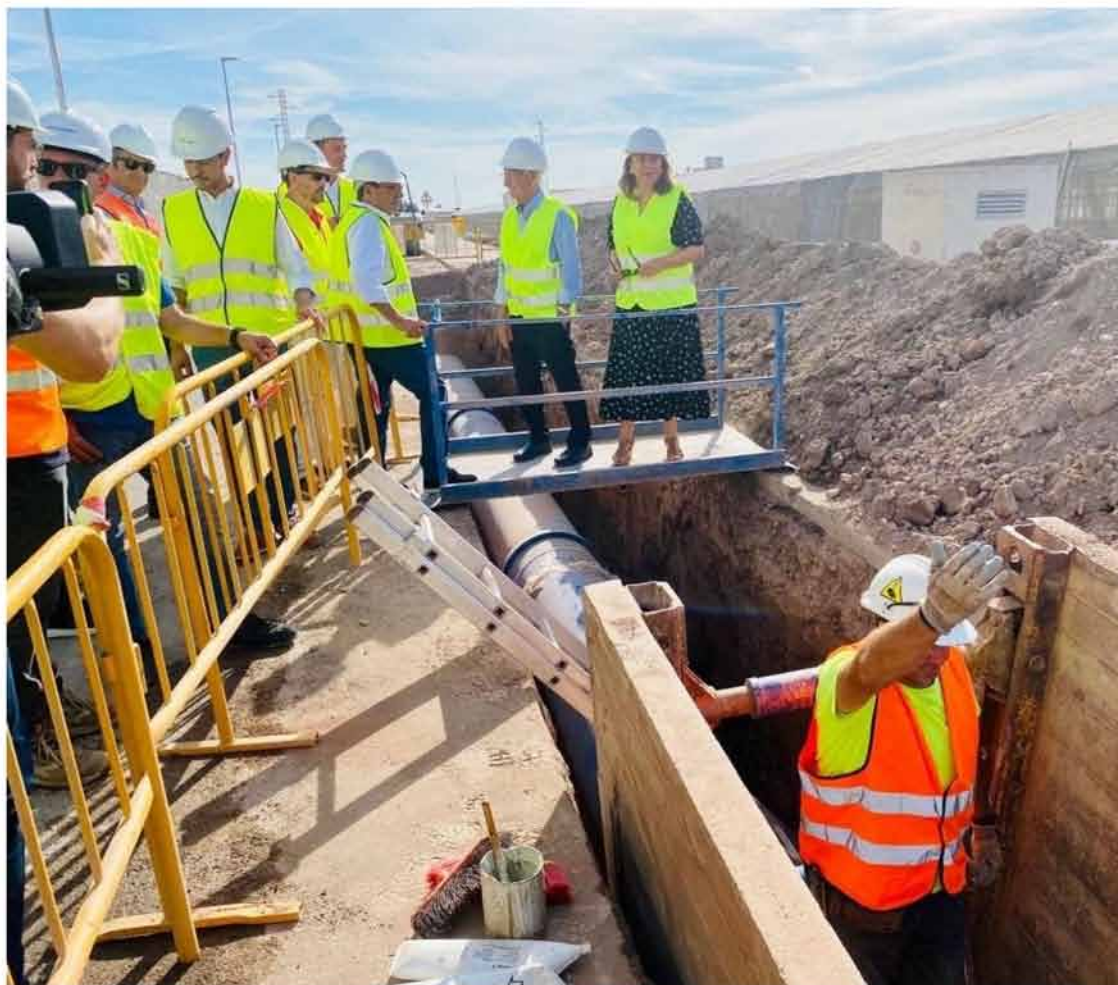
Visita de Carmen Crespo a la obra de abastecimiento en el alta en Roquetas de Mar
